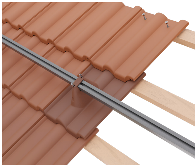
Zároveň šroubujeme původní střešní tašku, která překrývá tašku s konzolí z vrchu. Pokud nebude mít původní taška montážní otvor, tak použít vichrovou sponu.
